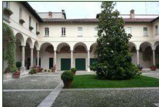
Vigevano (PV) Casa Privata Ex Monastero
